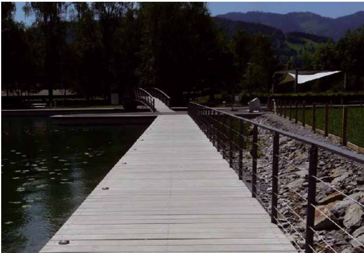
Carbonfaser armierter Belag für einen Steg (Quelle: www.silidur.ch )
